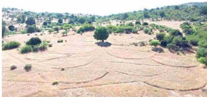
Se construyeron surcos medias lunas, en el caso de la plantación en claros y bancales en plantación en bosquetes, de tal manera de obtener una mayor sobrevivencia y adaptación de las plantas.
