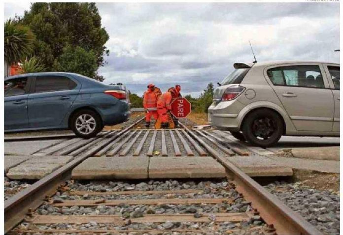
OPERARIOS DE EMPRESAS CONTRATISTAS DE EFE, REALIZAN EL MEJORAMIENTO DE LOS CRUCES FERROVIARIOS.
