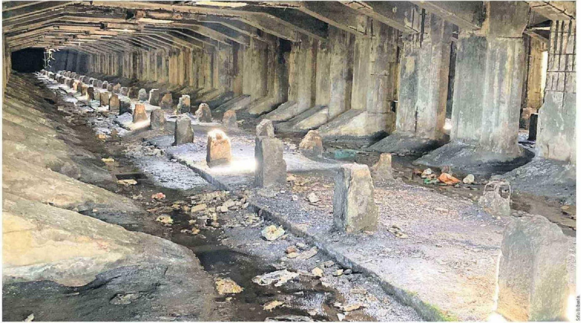
Un paisaje de naturaleza post apocalíptica es esta imagen del silo de almacenamiento del puerto de Enacar.
