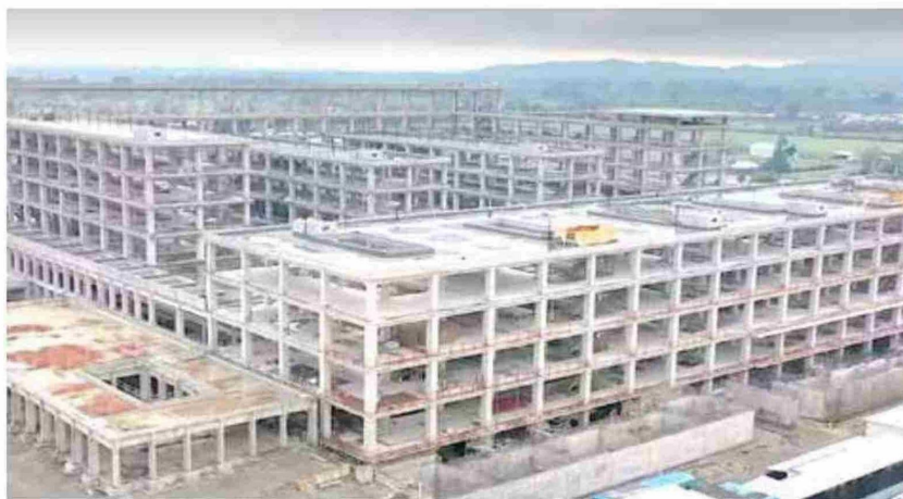
Las obras de construcción del nuevo Hospital de Linares, registran un 26% de avance y fueron paralizadas en medio de la pandemia debido al aumento en los precios de los materiales.
