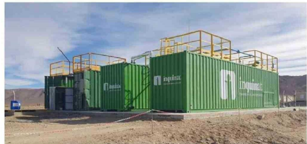
Planta de tratamiento de efluentes en contenedores, ideal para faenas mineras.
