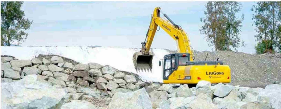
En la comuna de Rauco visitó las obras de enrocado del río Mataquito, en el sector Majadilla.
