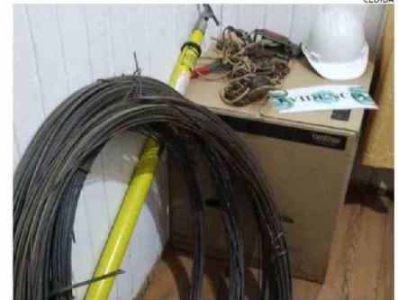
LOS CABLES ROBADOS Y LAS HERRAMIENTAS USADAS POR LOS LADRONES.
