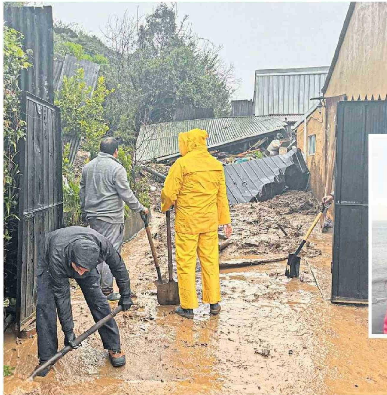
El cerro David Fuentes en Talcahuano fue una de las zonas afectadas por deslizamientos.
