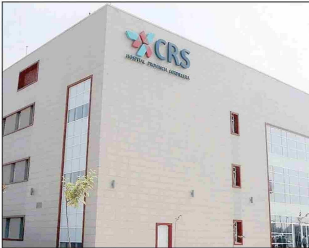
Hospital Provincia Cordillera, ubicado en Eyzaguirre 2061, Puente Alto.
