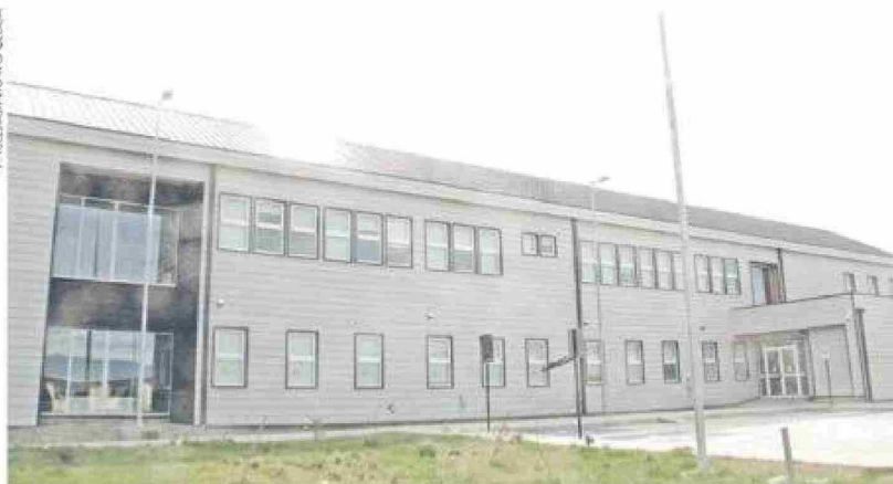
En el plano sembrado de pasto (en primer plano) de la fachada sur del Hospital Marco Chamorro Iglesias, se proyecta construir la sala destinada al tratamiento de diálisis para los pacientes renales de la provincia fueguina.
