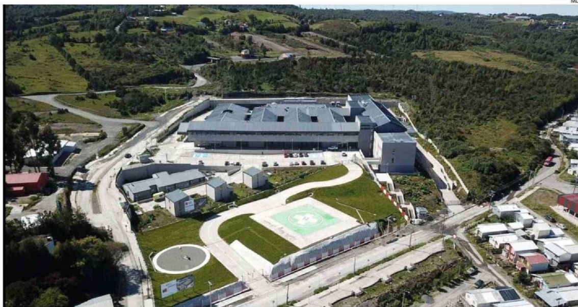
UNA DE LAS OBRAS DEL PLAN QUE SE ENCUENTRAN CONSTRUIDAS ES LA QUE SE EMPLAZA A UN COSTADO DEL NUEVO HOSPITAL DE QUELLÓN.
