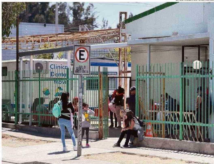
SAR RESULTA URGENTE: CESFAM DE LA ZONA YA NO DA ABASTO POR EL CRECIMIENTO DEL SECTOR.
