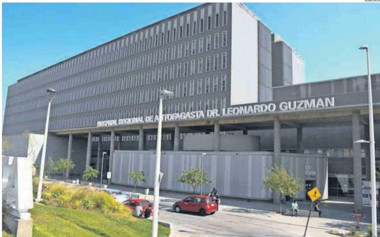
EL HOSPITAL REGIONAL DE ANTOFAGASTA HA SUFRIDO VARIOS INCIDENTES EN RELACIÓN A FILTRACIÓN DE AGUA POR EL SISTEMA DE CLIMATIZACIÓN.
