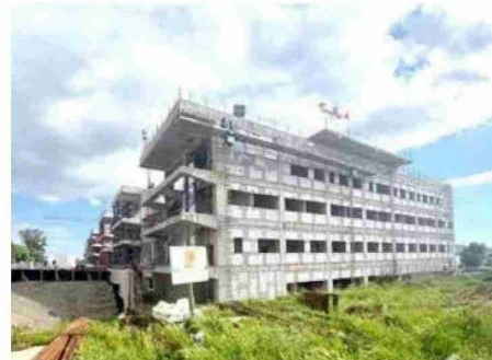
El nuevo recinto de salud con 42 mil m2, se construye en el terreno del ex-Regimiento Andalién, emplazado a un costado del estadio fiscal, en la zona alta de Cauquenes.
