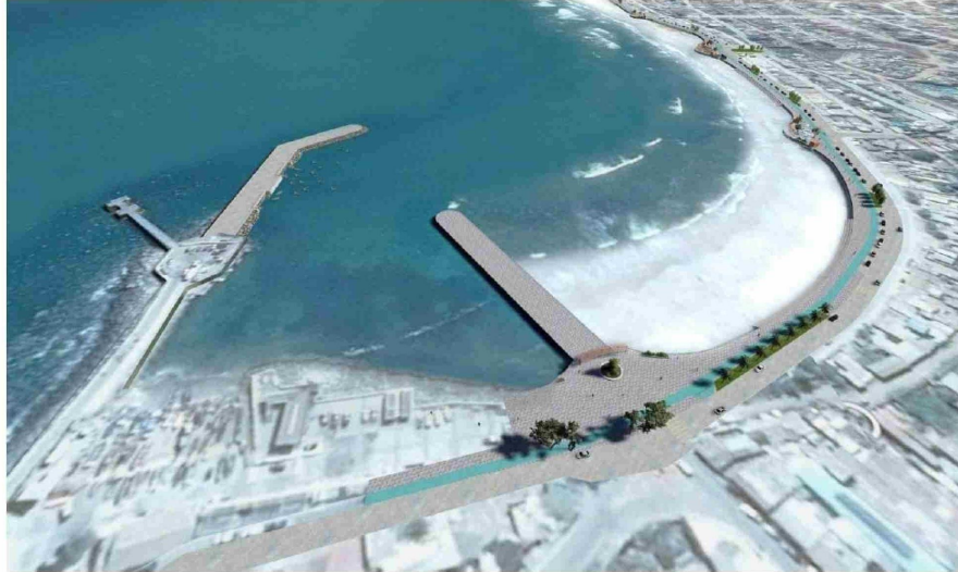
En la imagen, el proyecto de la Dirección de Obras Portuarias del MOP, cuyo objetivo es recuperar la playa de Los Vilos.
