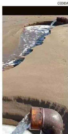
DESCARGA DE AGUA DE MAR.
