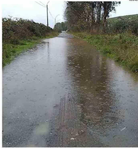
LA LLUVIA INUNDA EL CAMINO CON LÍQUIDOS QUE VIENEN DEL VERTEDERO.
