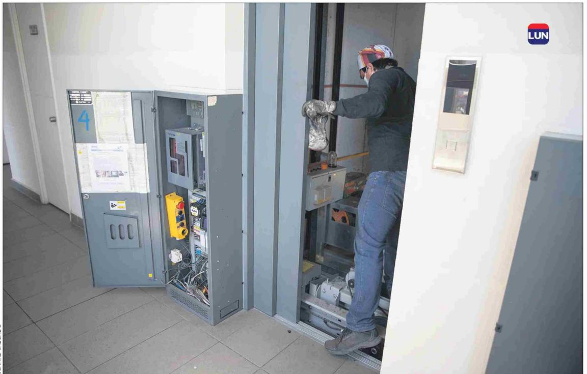
Con los cambios de voltaje, se pueden dañar los conectores, fusible, sensores y hasta los motores de un ascensor.
