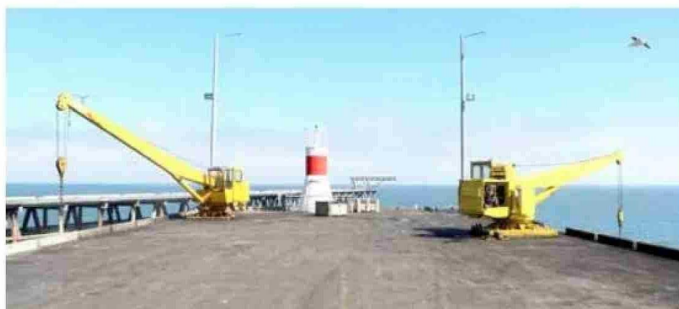
Solo una de las actuales tres grúas de izamiento del Puerto Maguillines, permanecen en buen estado. La sal, el agua de mar y el tiempo han hecho lo suyo.
