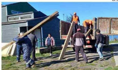
ARRIBO DE MATERIALES PARA CONSTRUCCIÓN DE CAMARINES,
