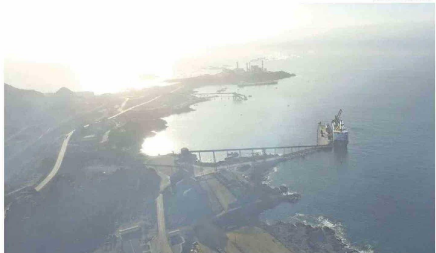
HUASCO TIENE EL MAYOR COMPLEJO DE GENERACIÓN TERMOELÉCTRICA DEL PAÍS, QUE ES CUESTIONADO POR ORGANIZACIONES AMBIENTALISTAS.
