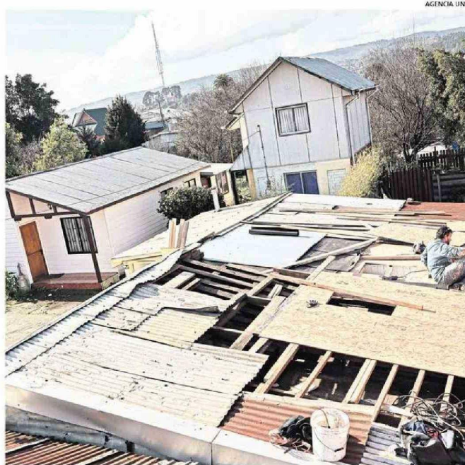
LAS VIVIENDAS AFECTADAS EN DISTINTOS SECTORES DE PENCO FUERON REPARADAS POR SUS MORADORES.
