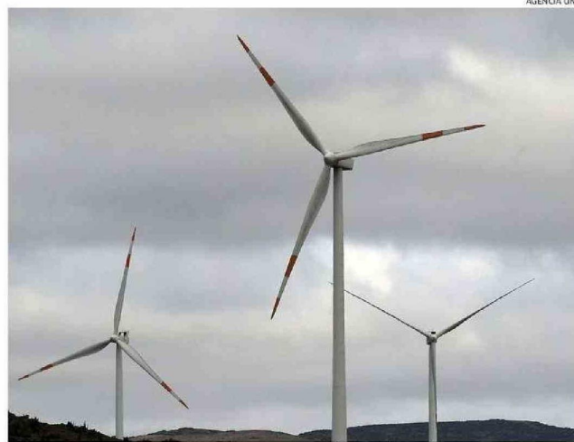
LOS PARQUES EÓLICOS SE HAN MULTIPLICADO EN CHILE EN LAS ÚLTIMAS DÉCADAS.
