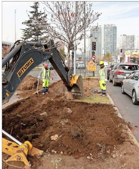
Los trabajos en la avenida Manquehue iniciaron el pasado 1 de junio, y se espera que el primer corredor biológico de la comuna esté operativo durante el segundo semestre.
