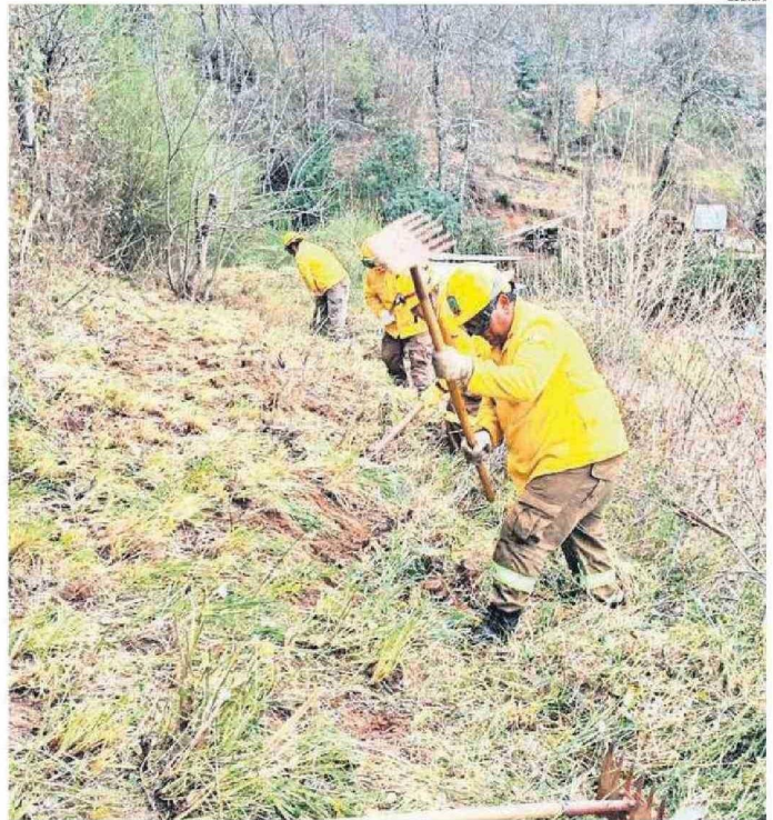
INTEGRANTES DE LA BRIGADA COMUNITARIA DE DE CHAIMÁVIDA TRABAJANDO EN LA REALIZACIÓN DE CORTAFUEGOS. SUS UNIFORMES CUMPLEN CON LOS REQUISITOS PARA EFECTUAR ESTOS TRABAJOS.
