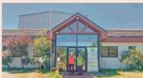
Frontis de planta de tratamiento de hidrocarburos residuales de origen marítimos y terrestres.
