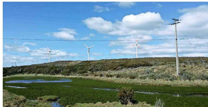
Parque eólico de Pecket Energy.
