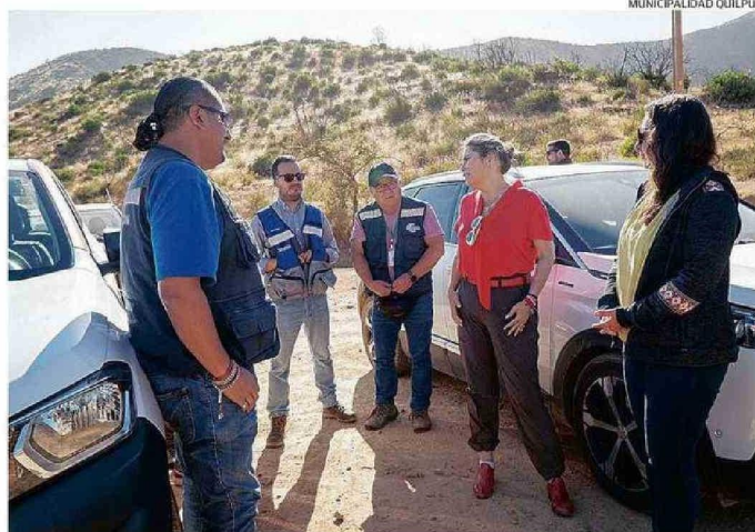
AUTORIDADES CONCURRIERON HASTA LAS FAENAS PARA NOTIFICAR LA PARALIZACIÓN DE LAS OBRAS.
