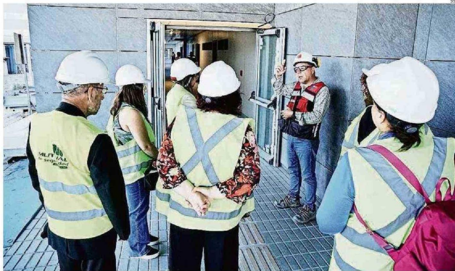
INTEGRANTES DEL CONSEJO DE DESARROLLO DEL CENTRO DE SALUD FAMILIAR VIOLETA PARRA VISITARON LAS OBRAS DEL NUEVO HOSPITAL.
