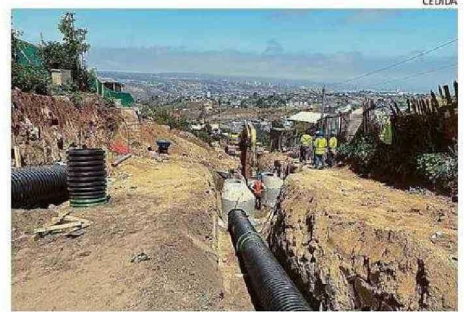
OBRAS CONTEMPLAN MOVIMIENTO DE TIERRA Y EXCAVACIONES.
