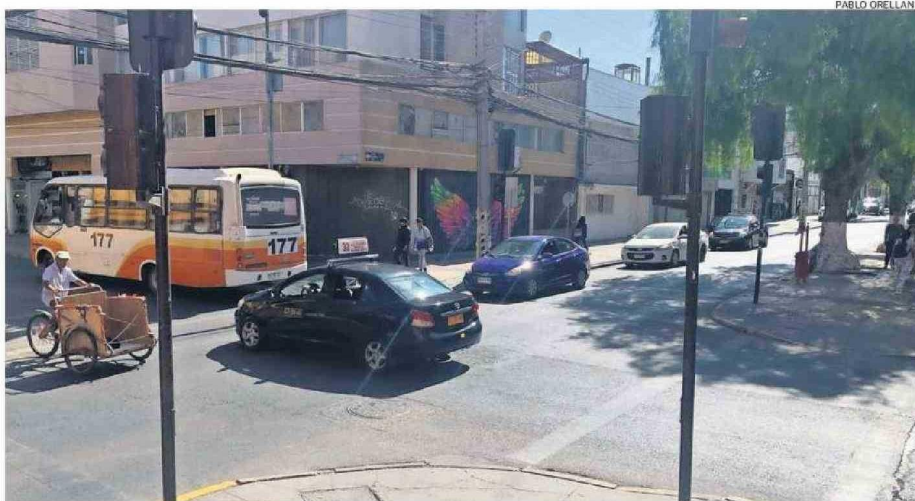
ALGUNOS SEMÁFOROS SE MANTUVIERON INHABILITADOS TRAS LA REPOSICIÓN DEL SUMINISTRO ELÉCTRICO EN CALAMA.
