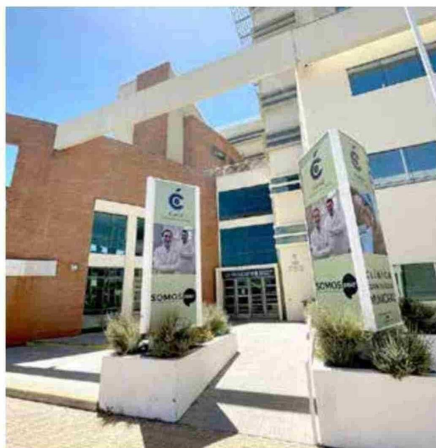
La Clínica Odontológica Municipal, está instalada en el antiguo edificio de La Araucana.
