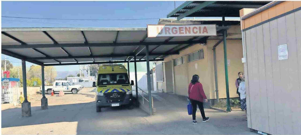
El municipio de Nacimiento acusa que su actual recinto hospitalario nunca ha recibido mantenimientos.
