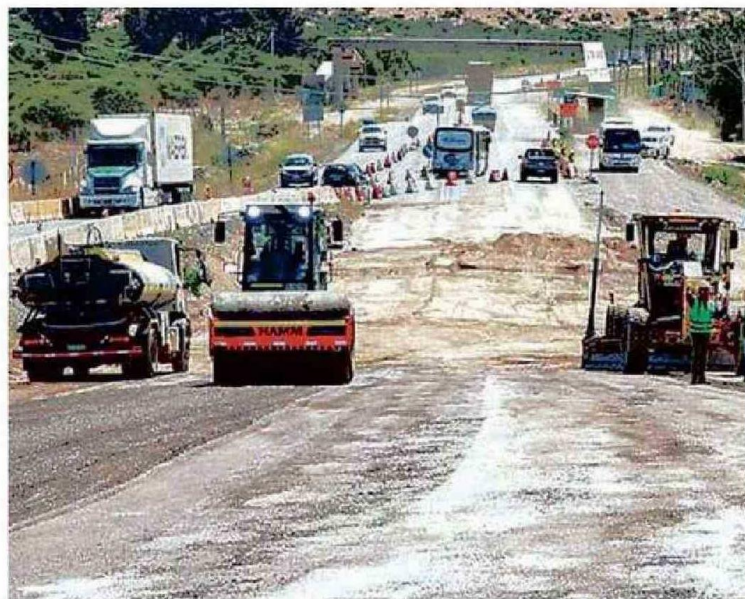
LAS OBRAS SON PARTE DE LA NUEVA CARRETERA DE LA FRUTA.
