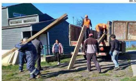
ARRIBO DE MATERIALES PARA CONSTRUCCIÓN DE CAMARINES,
