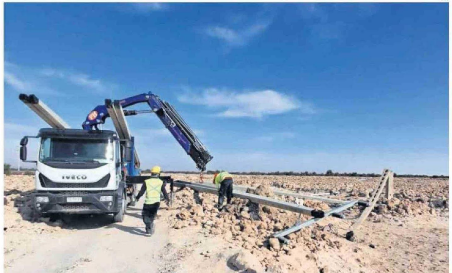
MIENTRAS SE INSTALAN LOS NUEVOS POSTES SE REALIZÓ UNA CONEXIÓN PROVISORIA A UNA RED PRIVADA QUE PERMITIÓ RESTABLECER EL SERVICIO.
