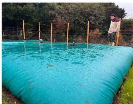
SISTEMA DE ACUMULACIÓN DE AGUA LLUVIA EN EL SECTOR CABEZA DE VACA, COMUNA DE ANCUD.
