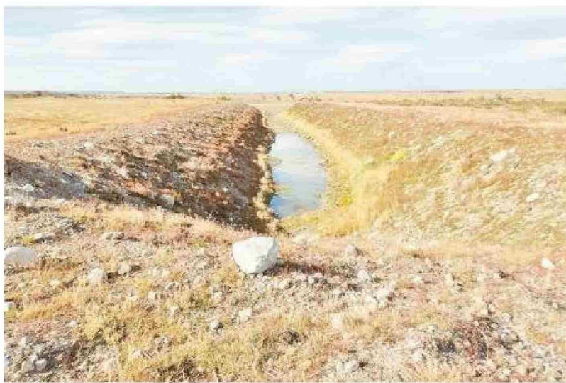
El proyecto consiste en la producción de áridos del Pozo Empréstito Zúñiga para su utilización como relleno de diversas obras.
