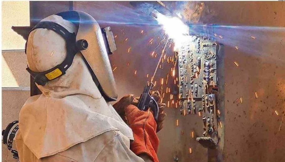
Montserrat se encuentra realizando un curso de soldadura certificado por el Sence.
