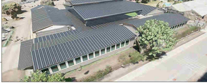
Este proyecto contempla el mejoramiento estructural del establecimiento.
