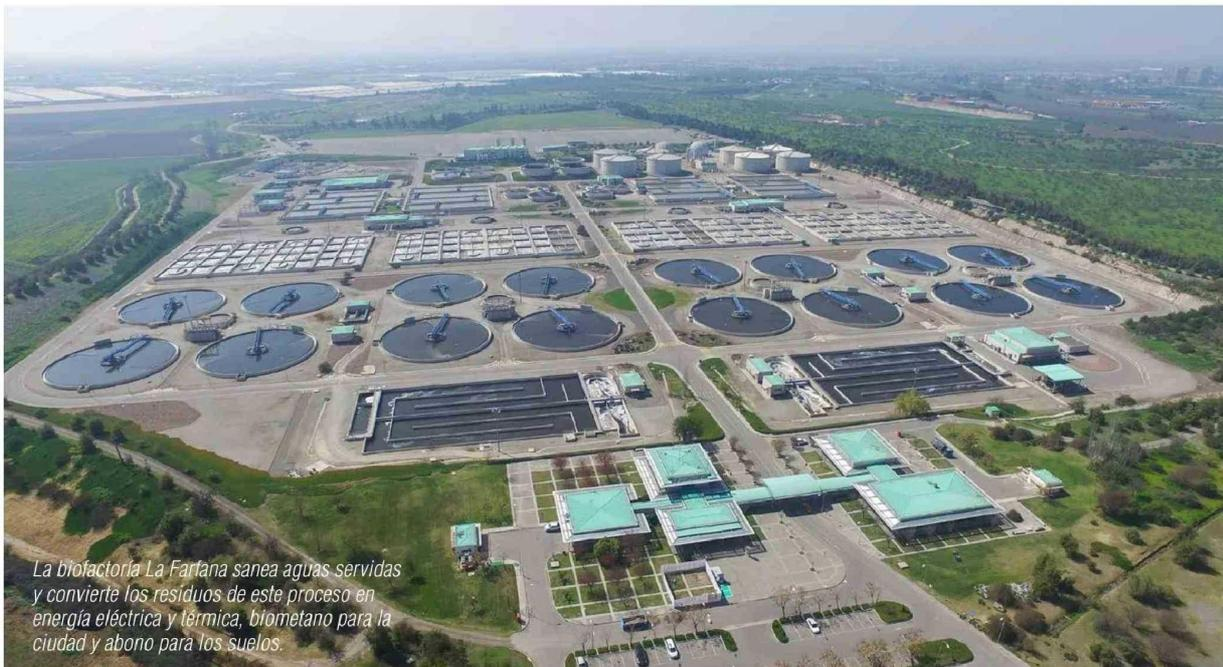
*La biofactoría La Farfana sana aguas servidas y convierte los residuos de este proceso en energía eléctrica y térmica, biometano para la ciudad y abono para los suelos.*
