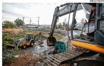
CON MAQUINARIAS INTENTABAN DESPEJAR CAUCES.
