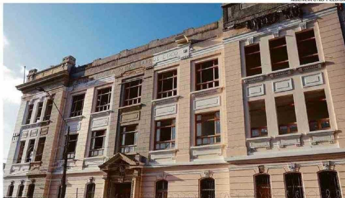
EL INMUEBLE, MONUMENTO HISTÓRICO, PERMANECE ABANDONADO DESDE EL TERREMOTO DE 2010.
