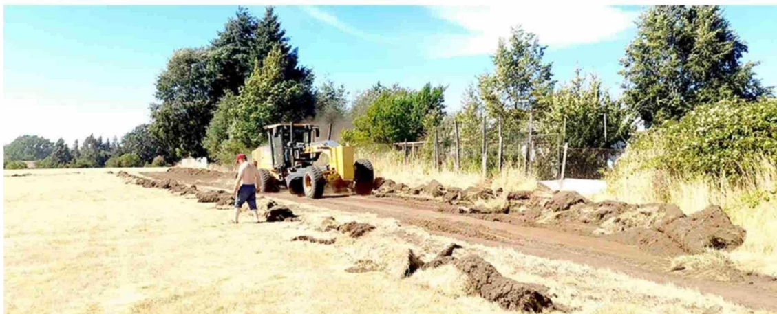
En caminos estatales y particulares, se realiza la limpieza de fajas, siendo las zonas de interfaz, urbano rural, las más intervenidas.
