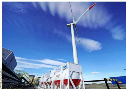
Planta Haru Oni de HIF Global, que utiliza energía eólica de la zona austral para su operación.
