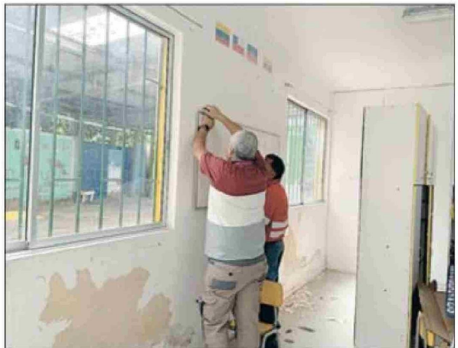
Los trabajos deberían estar listos dentro de los próximos días.
