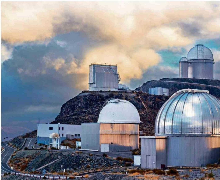
LA CONTAMINACIÓN LUMÍNICA, EL POLVO EN SU CONSTRUCCIÓN Y LAS TURBULENCIAS ATMOSFÉRICAS AFECTARÍAN LA OBSERVACIÓN, SEGÚN ESO.
