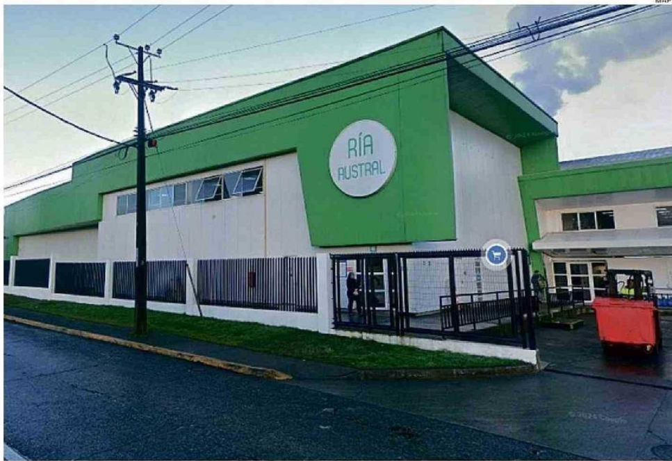
EN LA AVENIDA VICENTE PÉREZ ROSALES DE LA COMUNA DE LLANQUIHUE, ESTÁ EMPLAZADA LA PLANTA PROCESADORA DE PRODUCTOS DEL MAR.
