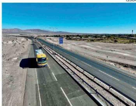
CADA LUMINARIA TIENE UNA POTENCIA DE 225 WATTS.
