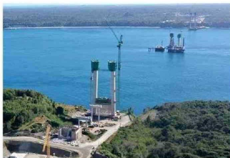
ESTABA PROGRAMADA UNA VISITA A LAS OBRAS DEL PUENTE.
